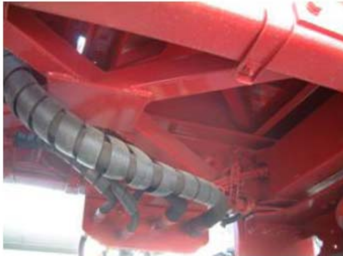
Exempel på kraftigt kryss av fyrkantrör.
